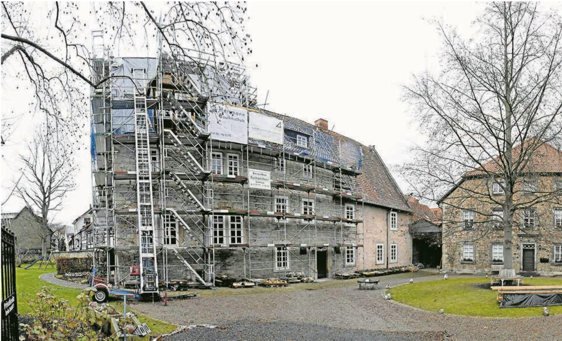
Nach der umfangreichen Sanierung des ersten Wohnhauses auf dem Redenhof (rechts im Bild) ist nun das Herrenhaus eingerüstet.
