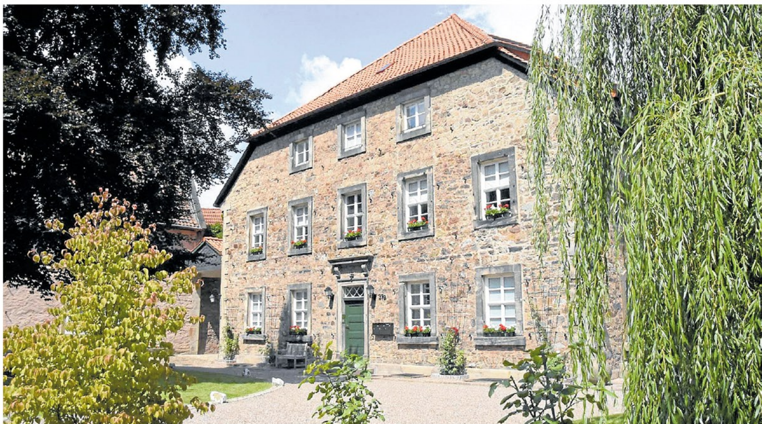
Eines der beiden Mehrfamilienhäuser des Redenhofs ist mitsamt der Parkanlage in den vergangenen Jahren aufwendig saniert worden. Die Sanierung des sogenannten Herrenhauses nebenan steht noch aus.
